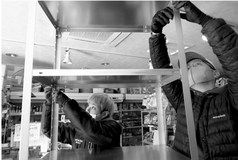
取引先の依頼で、店に新しい棚を設置する作業を行う「北摂ワーカーズ」のメンバーたち。これもつながりから生まれた仕事だ。
